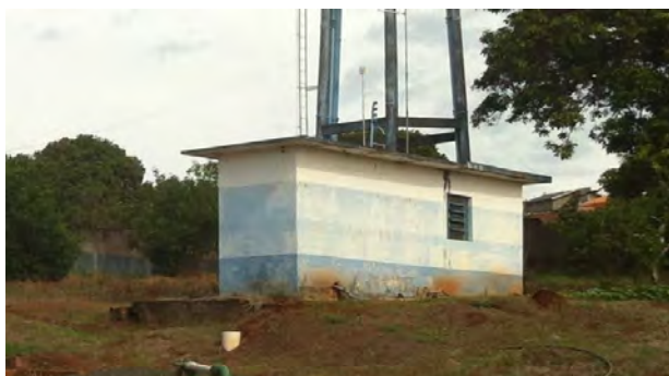
Vista externa da elevatória e abaixo do reservatório enterrado
