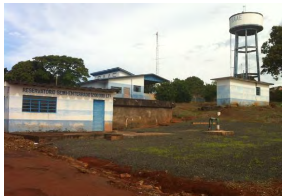
Vista da entrada da ETA
