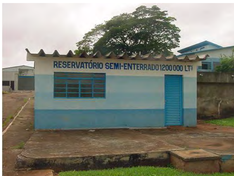
Figura 31 - Reservatório de água do SAAE na sede do Município
