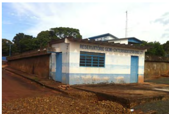
Reservatório semi-enterrado de 1.200m 3
