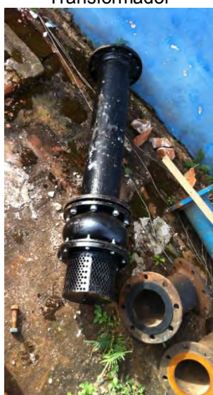
Nova tubulação de sucção com crivo
