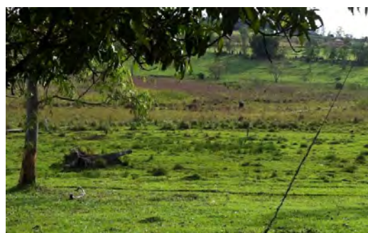
Tubulação aparente em direção à ETA
