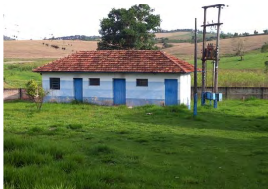
Vista externa da casa de bombas
