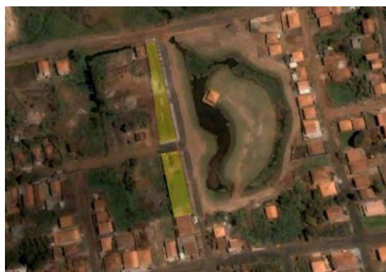
Vista do terreno dos poços 1 a 3 FONTE: Google Earth
