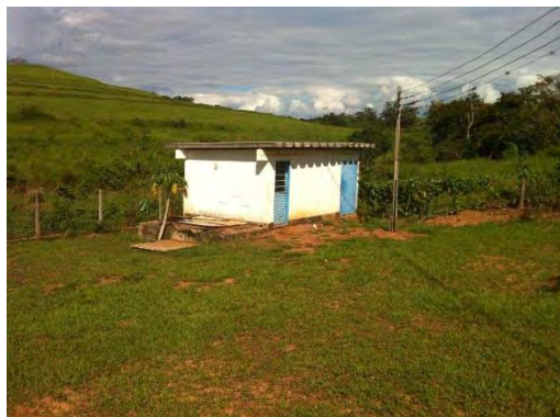
Terreno da elevatória de esgoto
