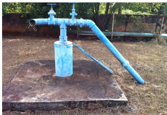
Vista externa do Poço 3
