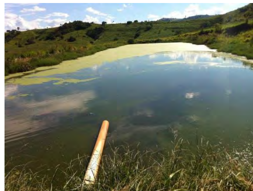
Tubulação de entrada do esgoto
