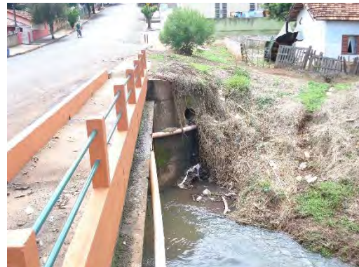
Ponte sobre o Ribeirão Claro
