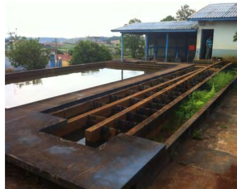
Floculador, Decantador e filtros
