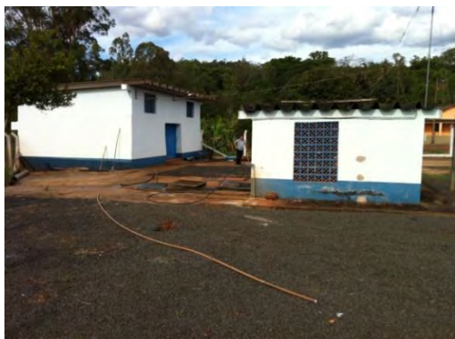
Vista externa casa de bombas e almoxarifado
