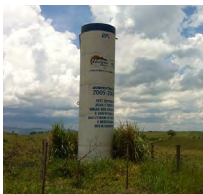
Figura 60 - Fotos (Reservatório de 10m 3 para Bairros Campo Alegre e Oliveiras) FONTE: UNILIVRE, 2.013.
