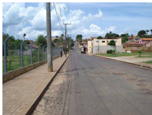
Coleta de águas pluviais pela sarjeta
