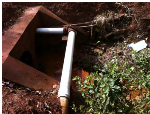
Travessia pela galeria de drenagem abaixo da rodovia PR 151
