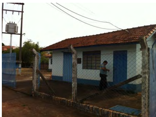
Vista externa da casa de bombas
