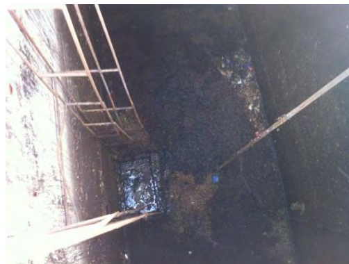
Poço de gradeamento e areia
