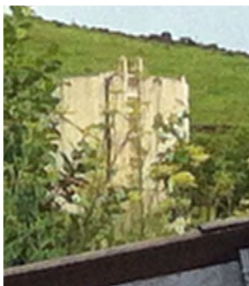
Figura 57 - Fotos (Reservatório apoiado de concreto de Cachoeira) FONTE: UNILIVRE, 2.013.
