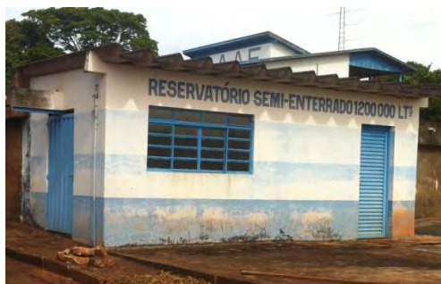
ERAT1 – Vista externa da casa de bombas
