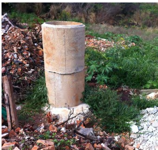
Vista externa do Poço 5
