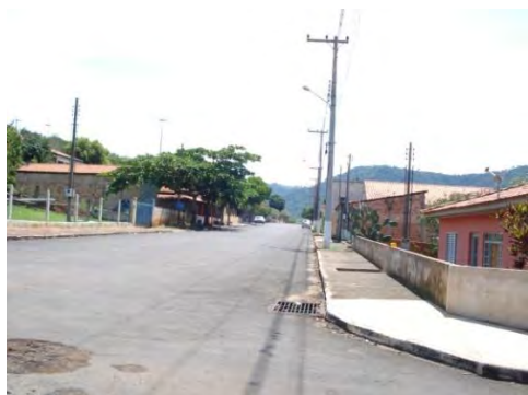
Microdrenagem urbana – Distrito Cachoeira
