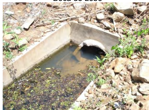
Lançamento de águas pluviais no Represa Xavantes
