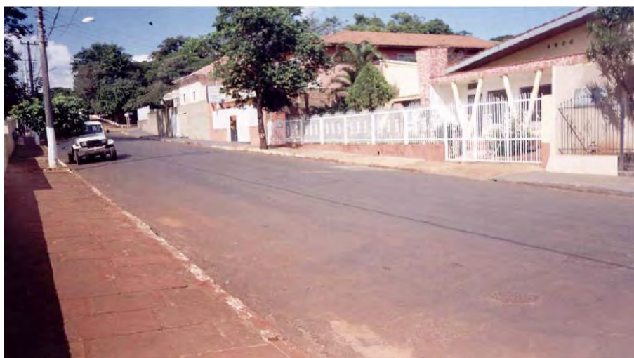
Figura 7 - Via secundária, pavimentação do passeio em arenito “Botucatu”
