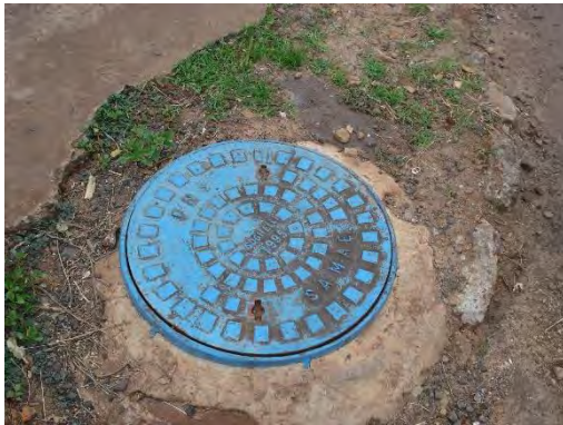
Poço de visita – SAAE
