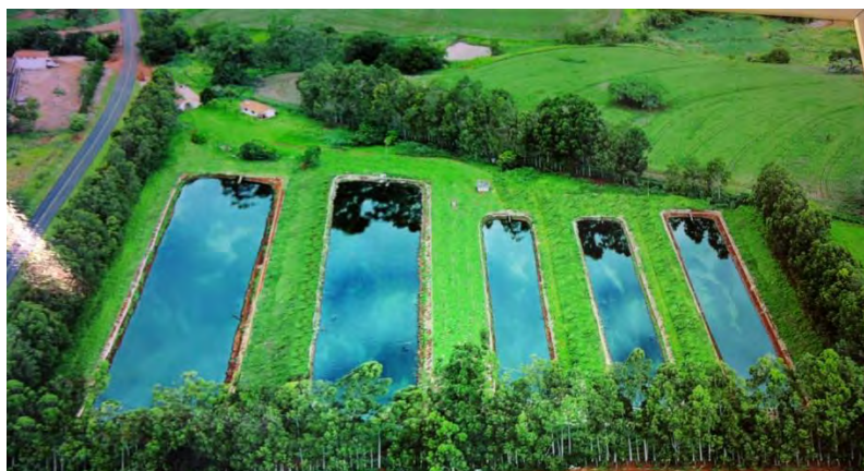
Figura 64 - Fotos (Vista aérea da ETE)
