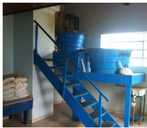
Preparação do coagulante sulfato de alumínio
