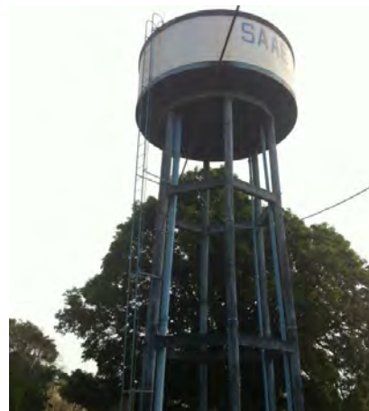
Reservatório elevado de 40m 3
