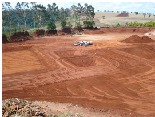
Figura 83 - Anexo fotográfico – Construção do Aterro Sanitário FONTE: UNILIVRE, 2.013.
