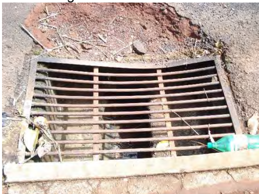
Boca de lobo em barras de ferro
