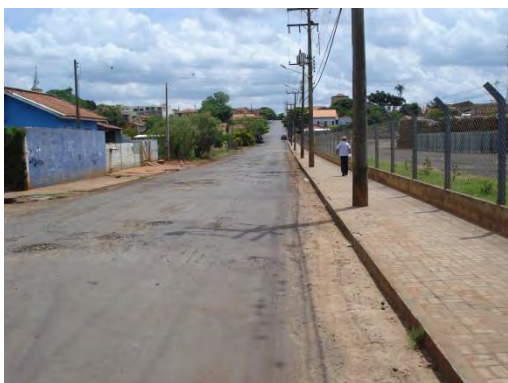
Coleta de águas pluviais pela sarjeta
