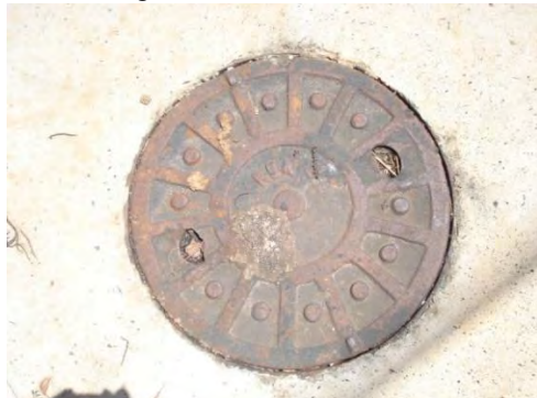
Poço de visita
