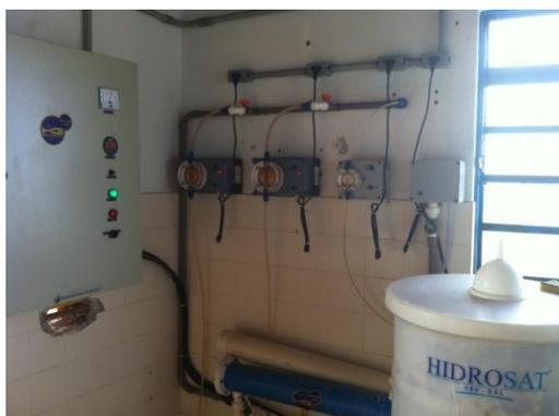
Gerador de cloro Hidrogeron, dosadoras e tanque de solução do sal (cloreto de sódio)
