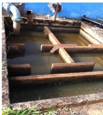
Sedimentação, poços de sucção e ao fundo a espera da nova tubulação de sucção
